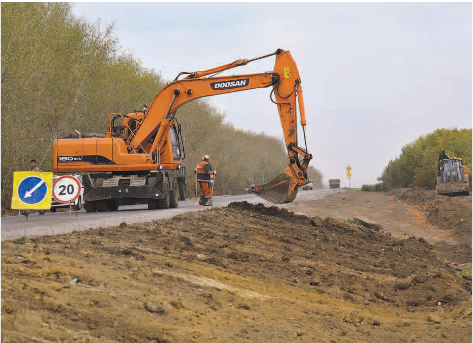
В этом году дорожники региона отремонтируют 99,2 км и ликвидируют 33 аварийно-опасных участка
