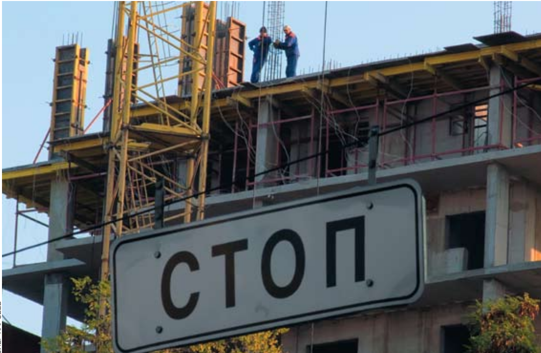
В повышенную зону риска попадают те строительные компании, у которых проекты находятся на начальной стадии
