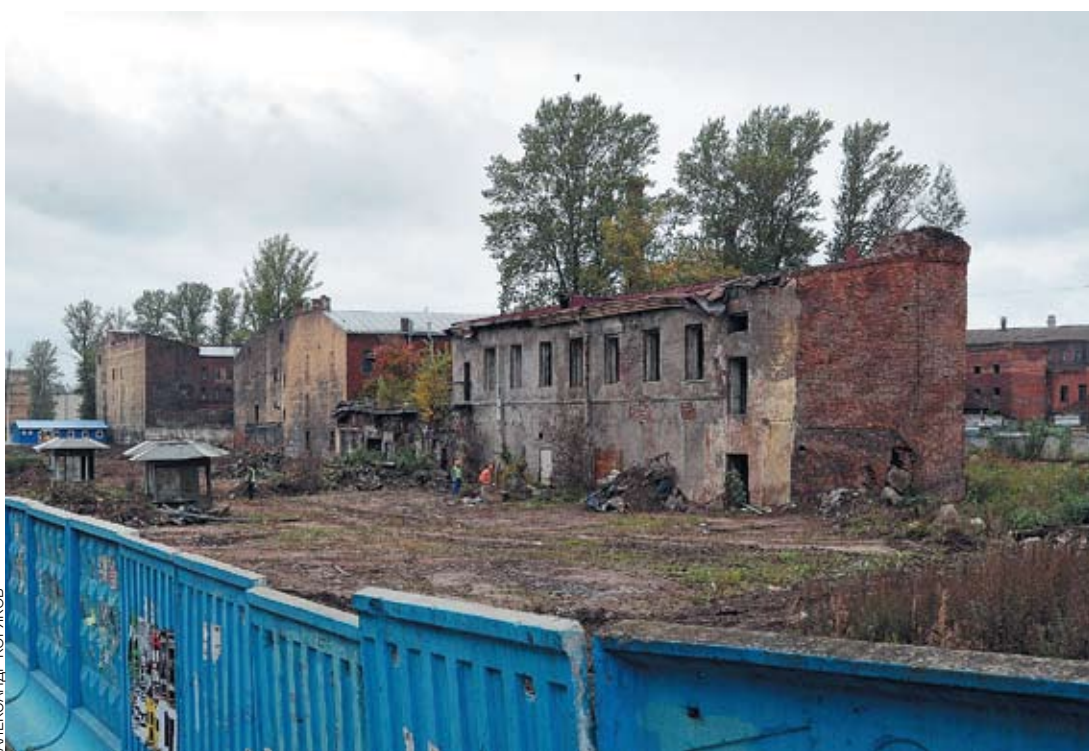
Проектов по строительству многофункциональных комплексов в Петербурге много, однако большинство из них пока находятся в начальной стадии
