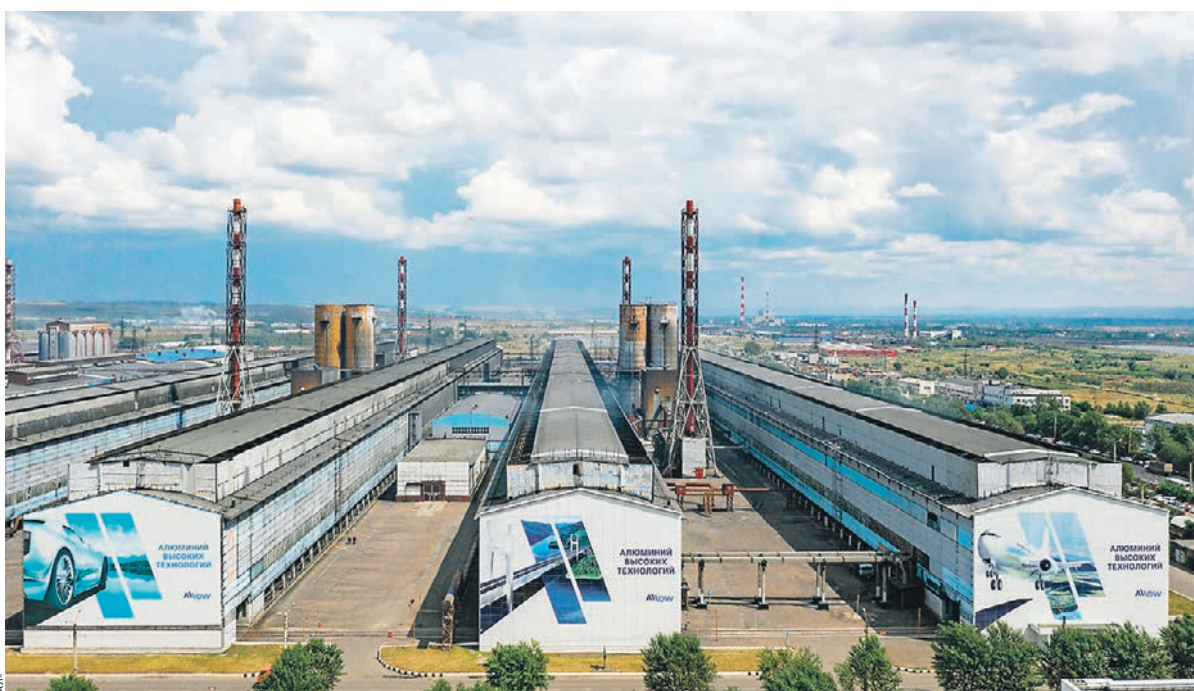
Красноярский алюминиевый завод стал первым в мире, где началось опытно-промышленное производство крылатого металла по революционной технологии инертных анодов
