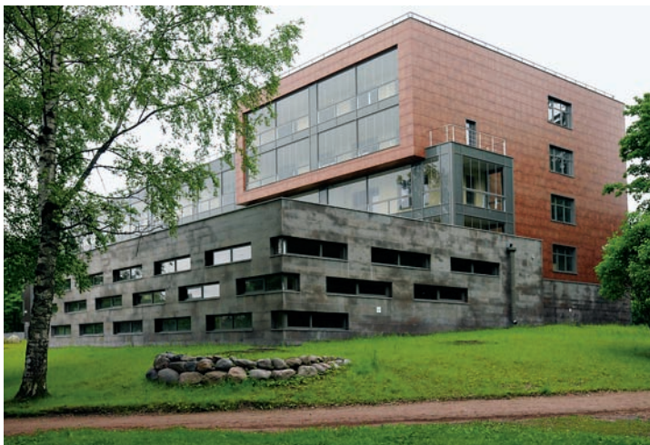
Компания «Невский альянс» построила дом в Зеленогорске в 300 метрах от берега Финского залива. ФОТО АЛЕКСАНДРА КОРЯКОВА
