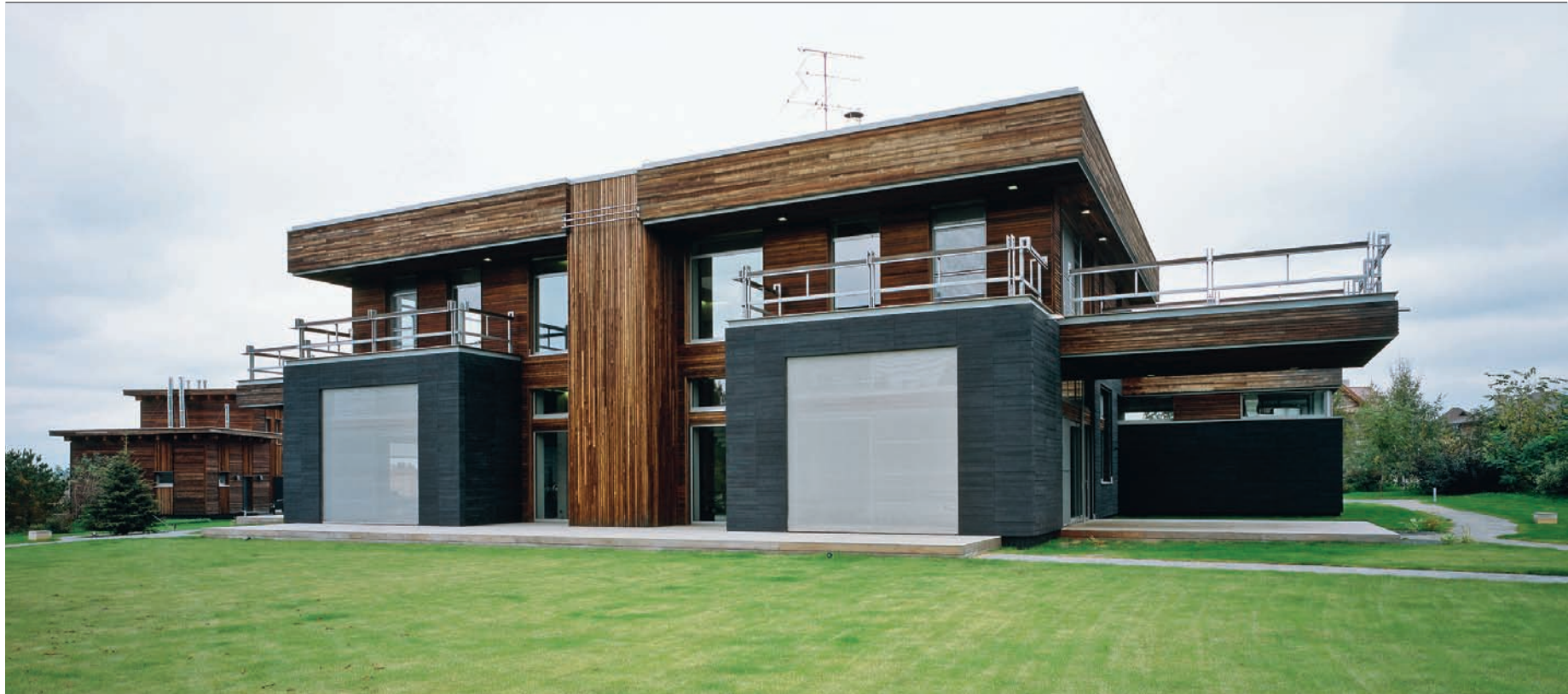
Т-house на Новорижском шоссе — визитная карточка архитекторов Ивана Чувелева и Натальи Лобановой ФОТО ARCH4
