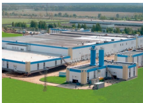
Юго-западная водопроводная станция
