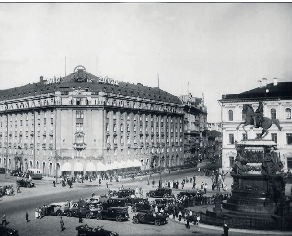
Гостиница «Астория»: в Ленинграде в 1934-м и в Петербурге в 2011-м
