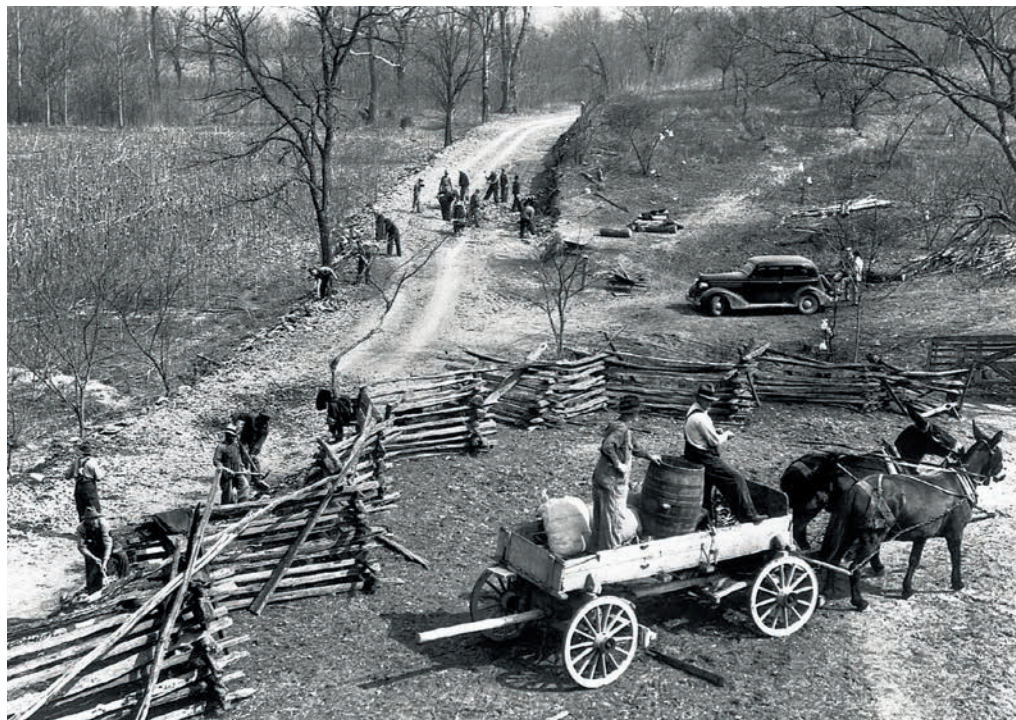
Кейнс считал, что общественные работы могут сыграть важную роль в борьбе с Великой депрессией. На фото — строительство дороги в штате Теннесси
